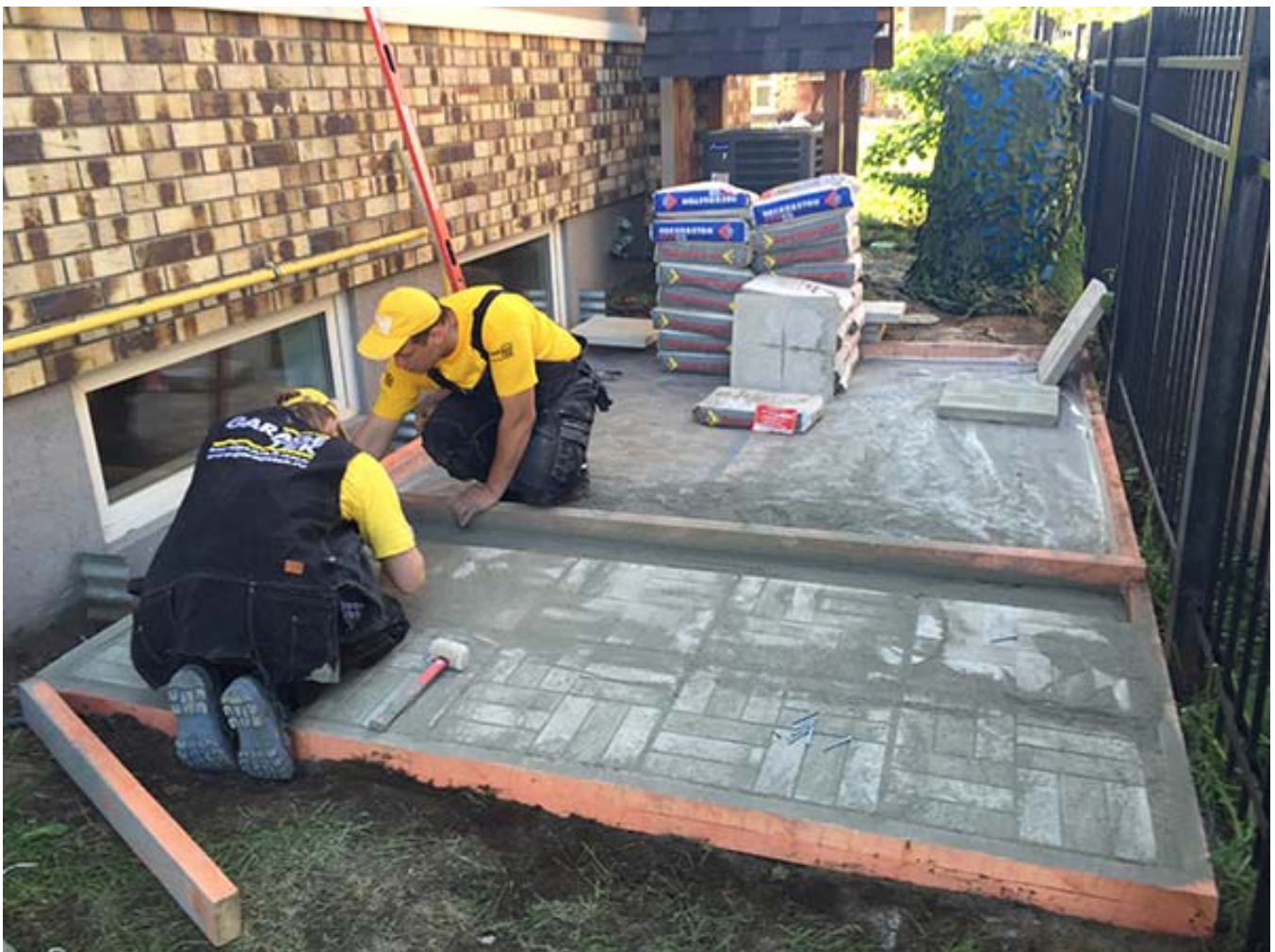
Подготовка основания под хозблок силами специалистов ГаражТек
