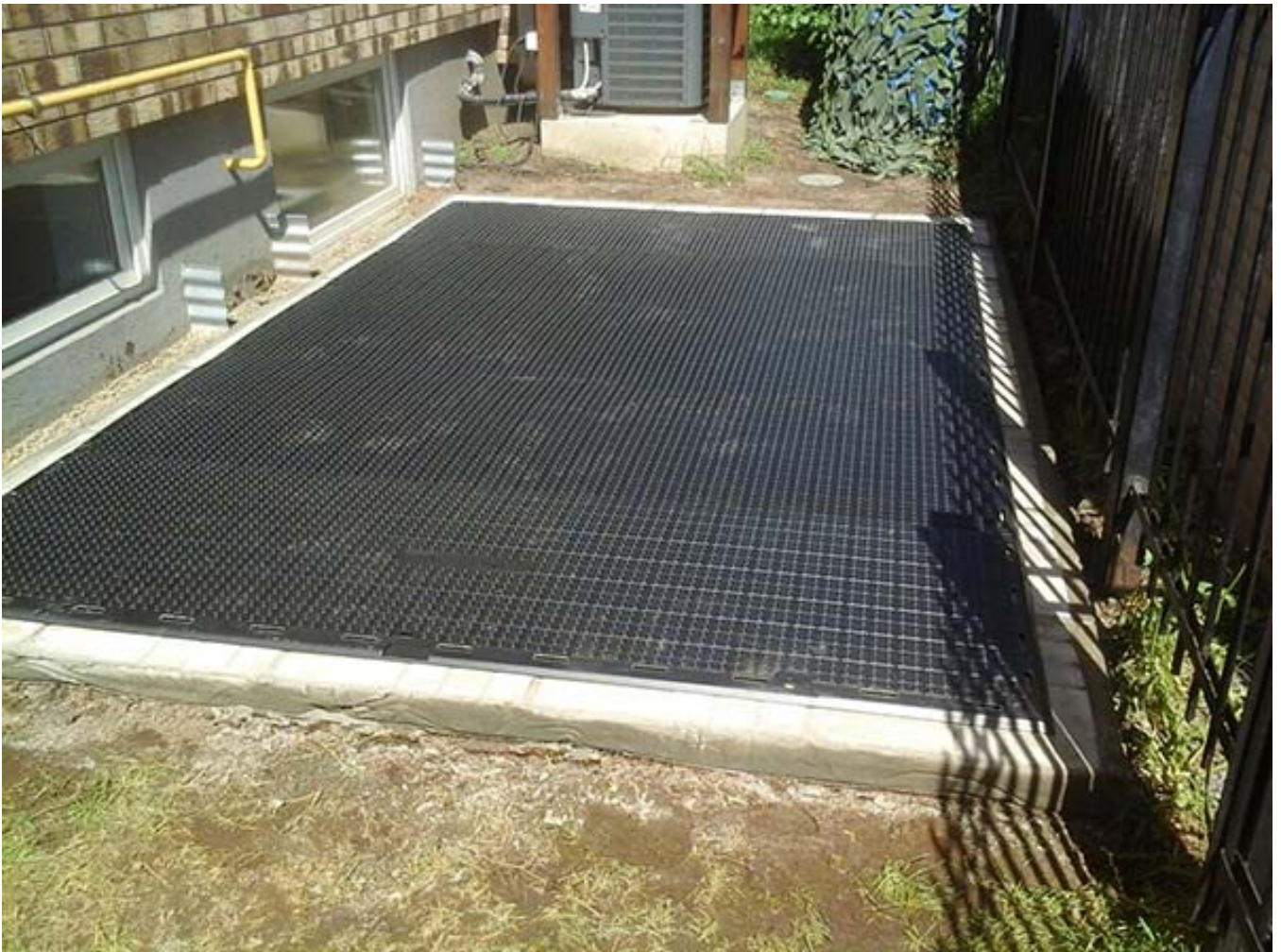
Основание с уложенным на него пластиковым полом из комплекта хозблока
